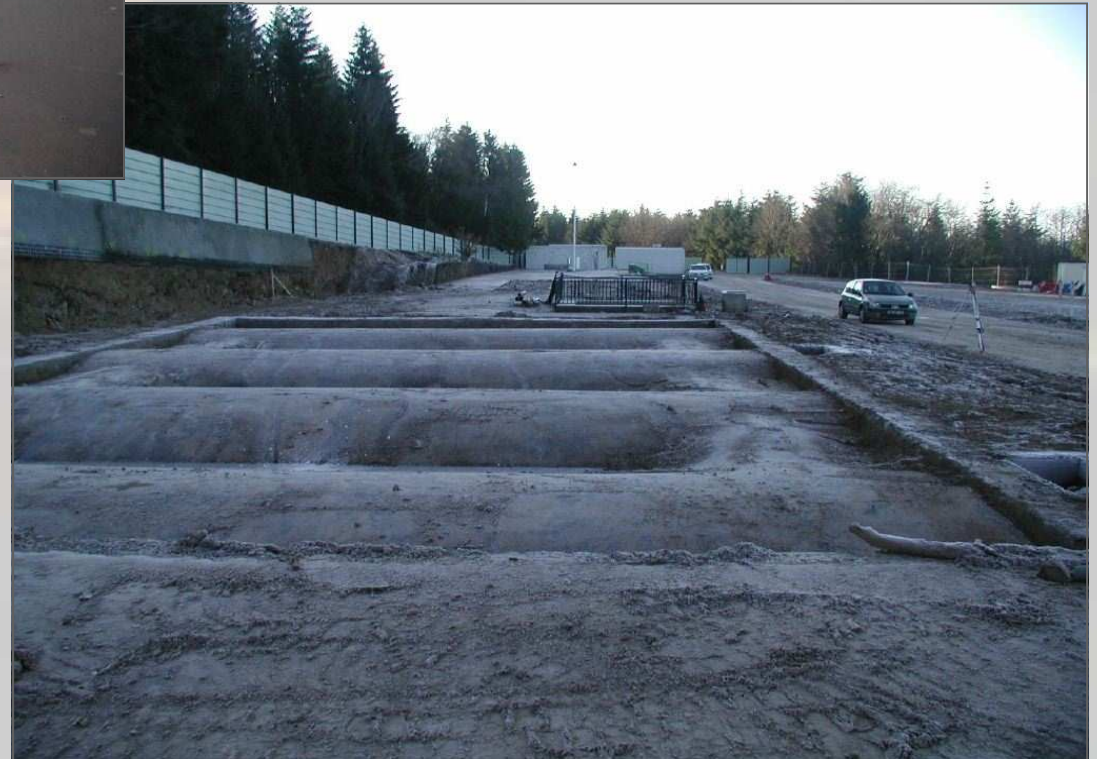
Travaux d'excavation de la Kartoffelkeller . 2003. © Ministère de la défense.
