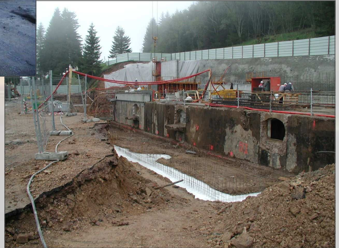
Travaux d'excavation de la Kartoffelkeller . 2003. © Ministère de la défense.
